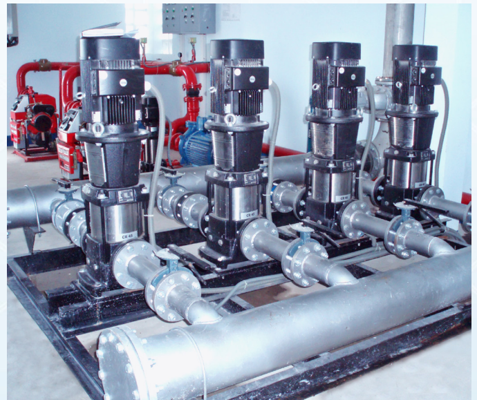
Chế tạo và lắp đặt hệ thống bơm điều áp Điều tiết nước từ máy trạm đến từng hộ dân
