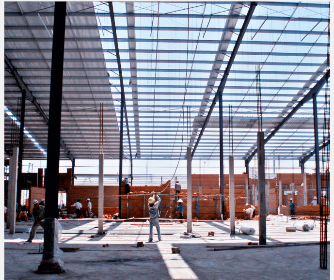
Thi công lắp - dựng nhà xưởng
