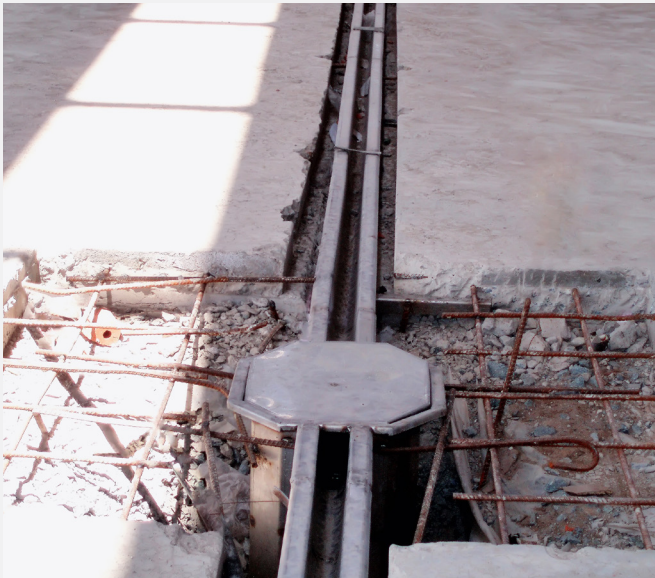
Thi công lắp đặt máng inox thu nước thải
