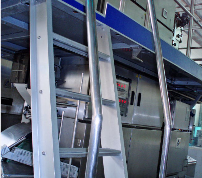
Chế tạo và lắp đặt sàn thao tác bằng inox Bắt ngang giàn giáo để làm mặt sàn di chuyển khi thi công
