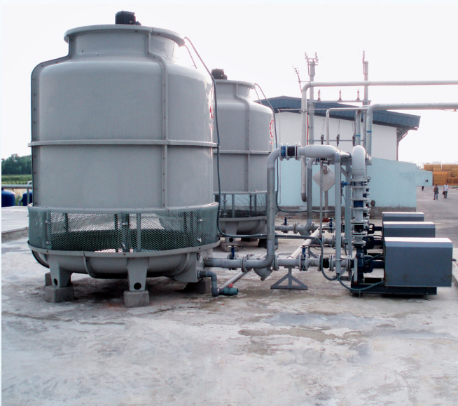
Lắp đặt đường ống và bơm nước tản nhiệt Bơm nước & tản nhiệt cho xí nghiệp, công trình
